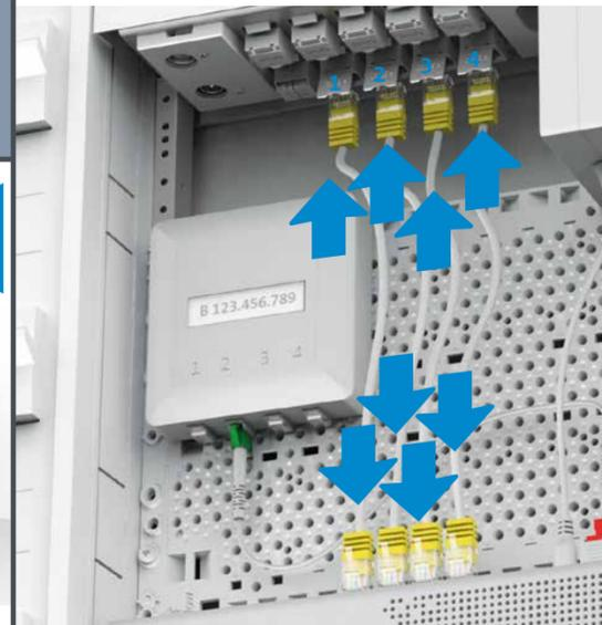
Die Anschlüsse im Verteilerkasten entsprechen den Netzwerkanschlüssen in Ihren Zimmern (gleiche Nummer). Dort können Sie Geräte per Kabel mit dem Internet verbinden.
